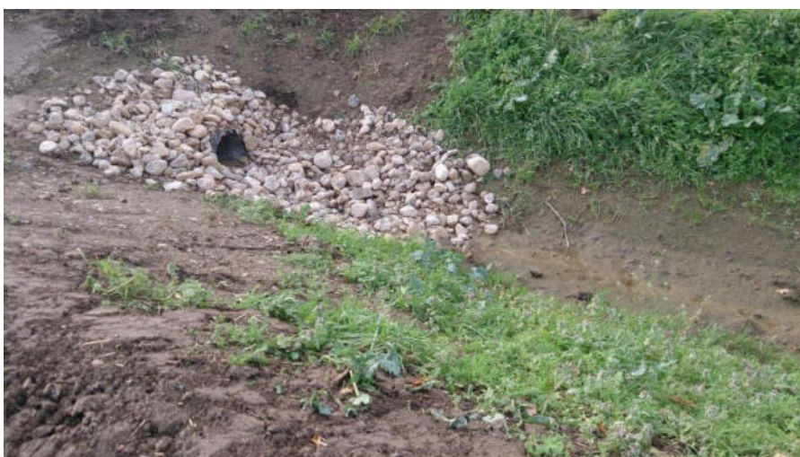
Figur 30 Udløb løftet 5 mm over grøftbund, med stensikring
