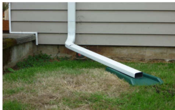
Figur 3 Princip 2 lokalnedsivning eks. i haven (Gabriel, 2017, s. 14-18)
