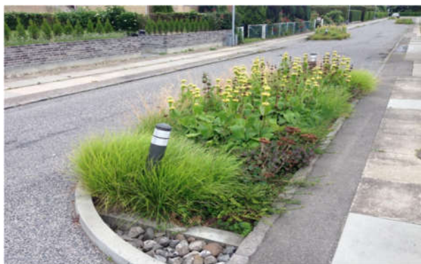
Figur 2 Princip 1 afledning i regnbed (Gabriel, 2017, s. 14-18)
