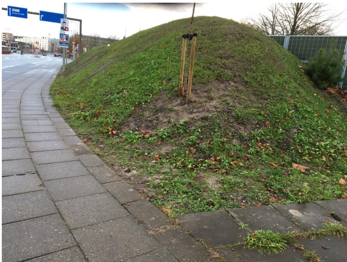
Figur 9: Støjvold etableret for at afskærme den nyåbnede børnehave i Karolinelunden.
