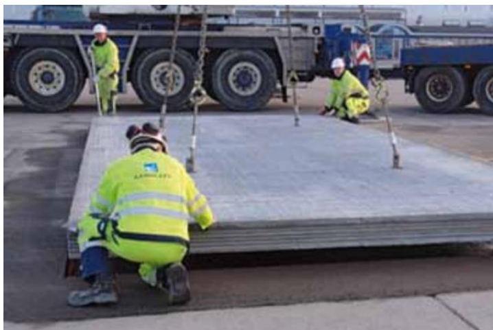
Figur 8: Etablering af præfabrikerede betonplader i Københavns Lufthavn (Saleem & Westergaard, 2012).
