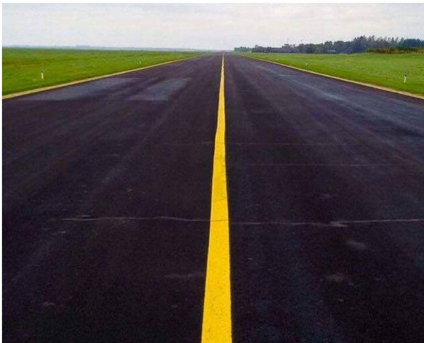
Figur 3: Landingsbane i asfalt på Flyvestation Aalborg.
