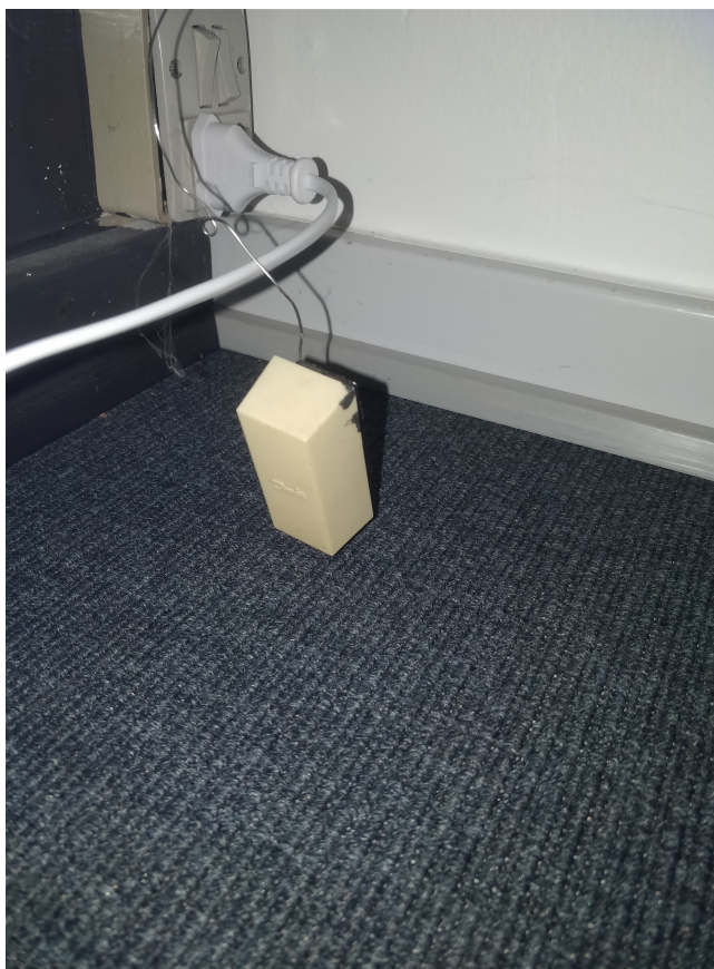
Figur 3.2: Termostaten til radiatorerne, denne lagde på gulvet.
