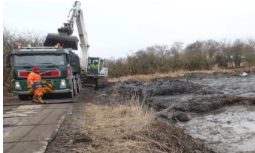
Figur 2.9: Opgravning i tørlagt bassin. [DANVA, 2016, Figur 6-10]
