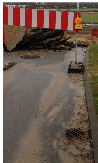
Figur 5.8: Brønd 1.2 ved vejomlægningen.
