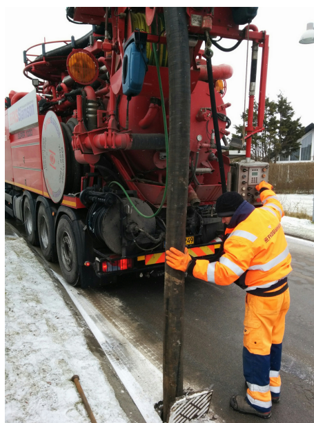
Figur 6.1: Slamsugning af sandfang i vejbrønd.
