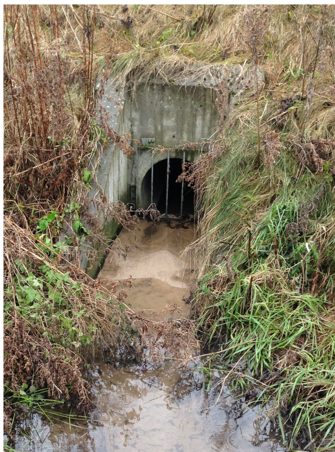
Figur F.4: Konstruktionssand ved indløb af bassin.
