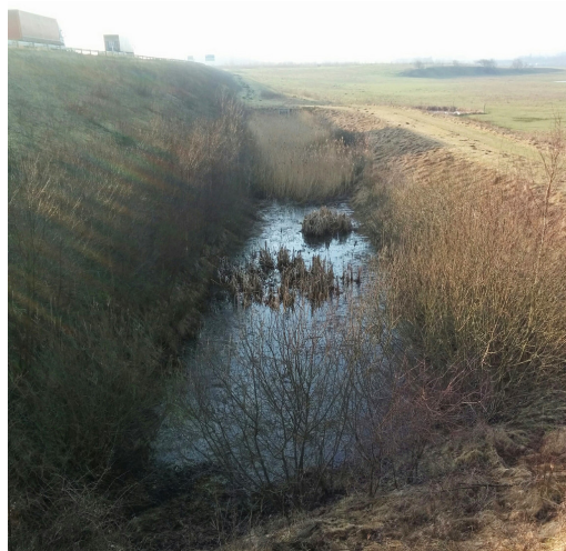
Figur 2.4: Aflangt vådt bassin ved E45 ud til Juelstrup Sø (d. 23/01/17).
