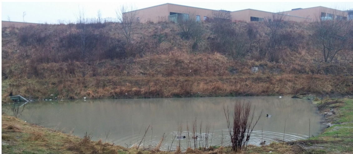
Figur 2.5: Vådt bassin på Eternitten Aalborg (d. 05/02/17).
