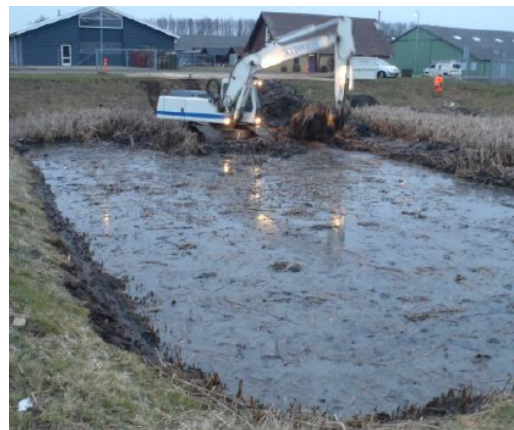
Figur 2.7: Opgravning i vådt bassin. [DANVA, 2016, Figur 6-4]
