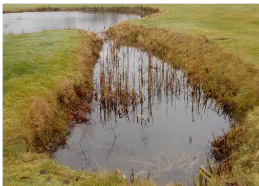
Figur 2.3: Forbassin foran vådt bassin ved Nordjyske i Aalborg (d. 05/02/17).
