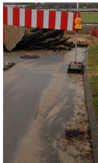
Figur D.1: Brønd 1.2 ved vejomlægningen.
