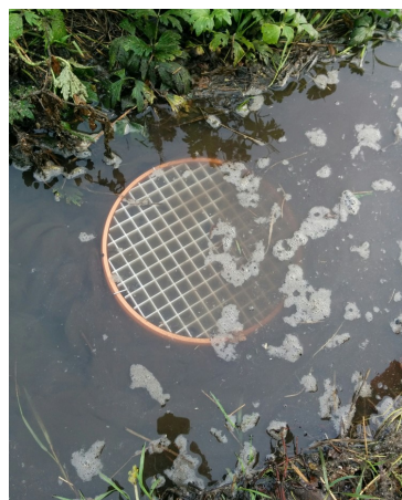
Figur 5.10: Sedimentfælde nedgravet i bassin.
