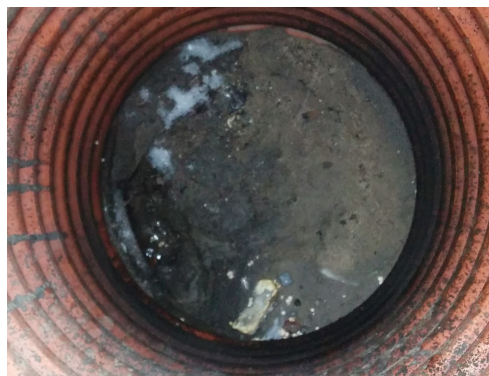
Figur 6.3: Strømningsvej i sandfang for brønd 1.8, fordybning i venstre side af billedet.
