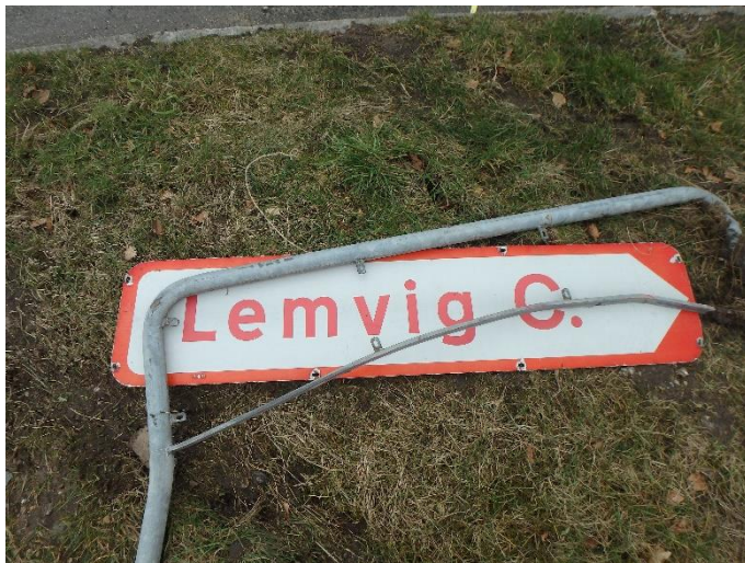
Figur C.2: Skade på et vejvisningsskilt.
