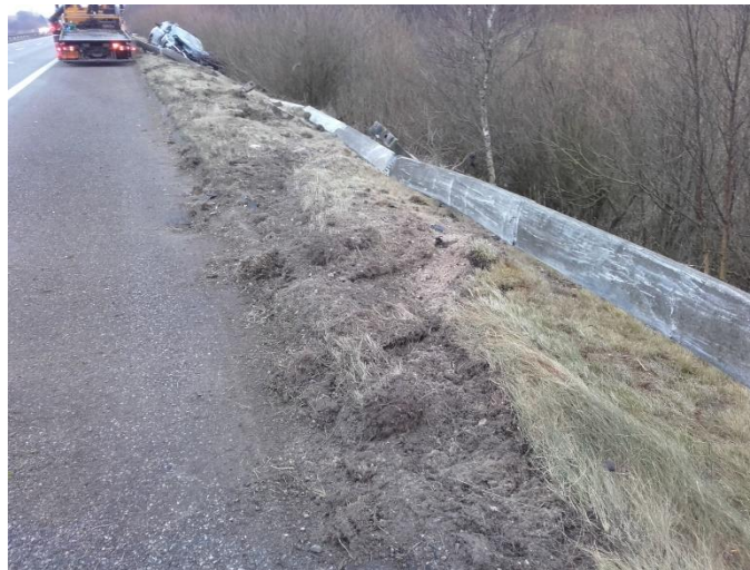
Figur C.5: Eksempel på rabatskade på motorvej.
