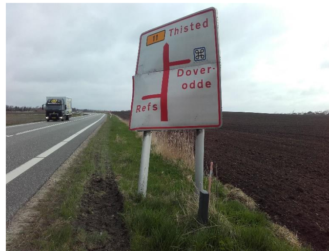
Figur C.3: Skade på en orienteringstavle.
