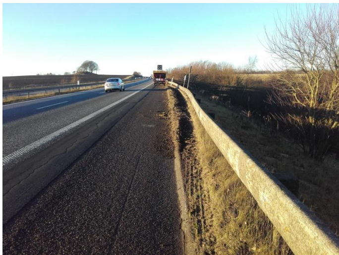
Figur C.6: Eksempel på rabatskade på motorvej.
