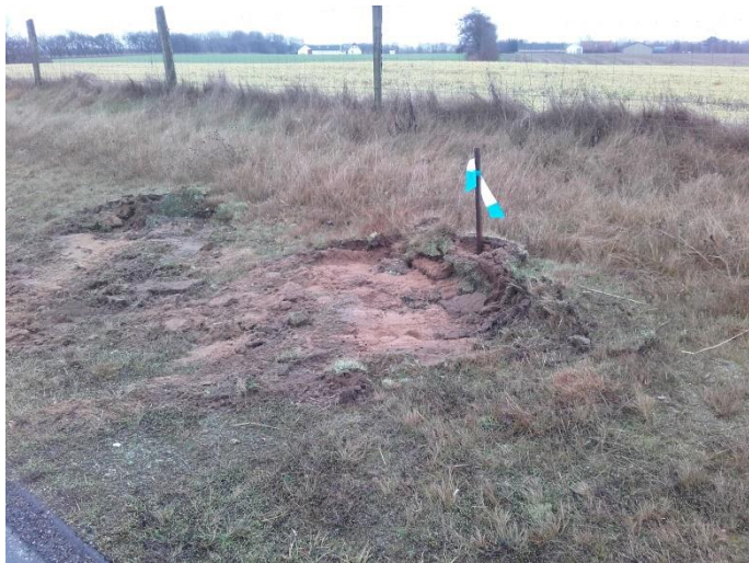
Figur C.4: Eksempel på rabatskade.
