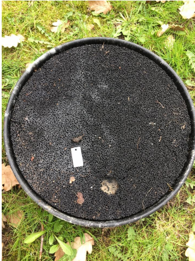
Figur B8.1. Hybrid Brøndkarmsfilter anvendt til optimeringsforøg. Filteret har siddet i en brønd for enden af en offerledning i Hjarup og har været udsat for stor belastning af svovlbrinte.
