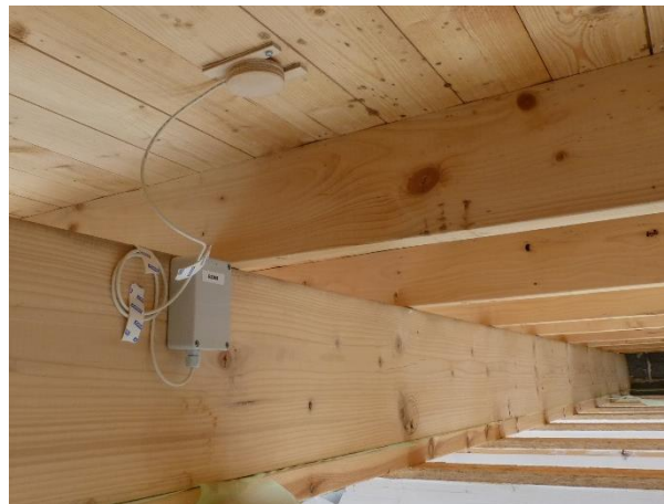
Foto 2: Placering af elektronisk fugtrondel i tagkonstruktionen
