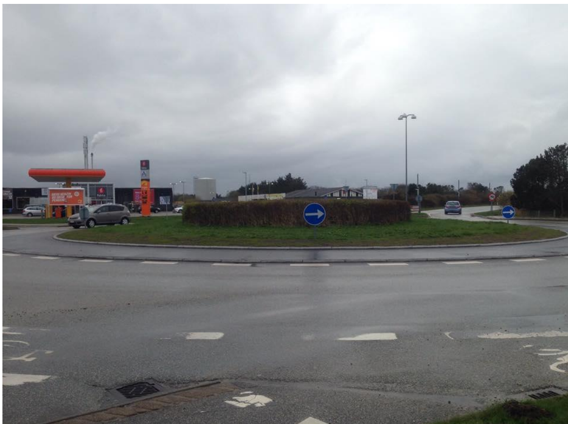
Figur 3.14: Rundkørslen efter ombygningen set mod den sydvestløbende Løkkensvej.
