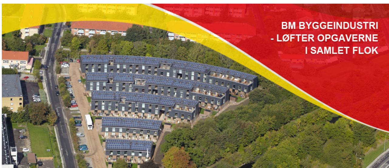
Figur 9.2 – Danmarksgrundene Rødovre udført af BM Byggeindustri (BM Byggeindustri 2013)
