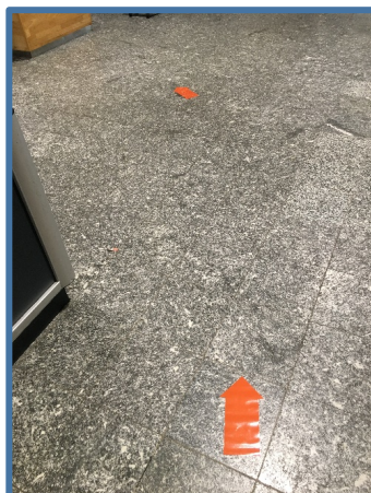
Figur 30 – Pile på gulvet
