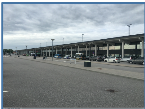
Figur 12 – Billede af lufthavnens hovedbygning
