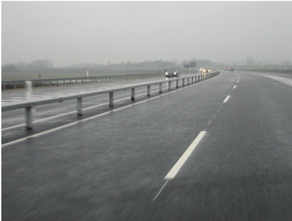
FIGUR 7.3 EKSEMPEL AF MIDTERADSKILLELSE MED STIFT AUTOVÆRN (VEJDIREKTORATET, 2016)
