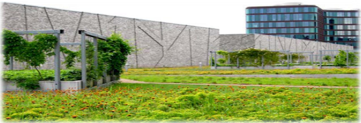
Figur 13: Rigsarkivet set fra den grønne tagterrasse. På tagterrassen opsamles regnvand og de grønne beplantninger bidrager til et forbedret mikroklima. (Skov & Landskab 2013, 14)
