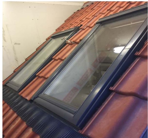
Billede 12: Færdig udvendig tagkonstruktion
