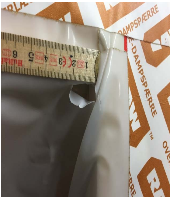
Billede 3: Illustration af perforering af dampspærre ved samling mellem lysning og væg
