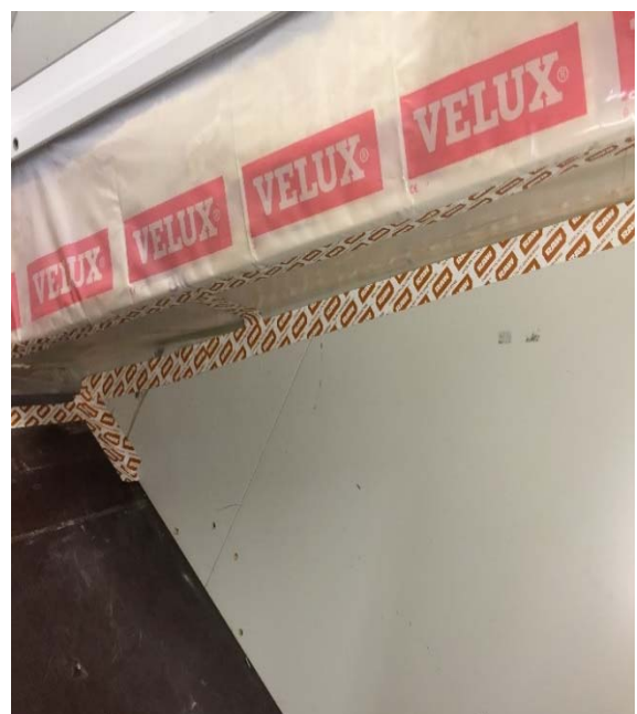
Billede 2: Billede af lysning og væg med færdig monteret dampspærre
