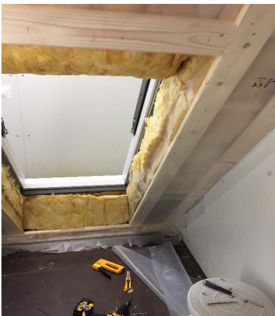
Billede 1: Indvendig konstruktion for færdig monteret dampspærre
