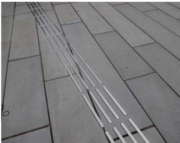
Figur 78: Påmonteret ledelinje, type 4C. Foto forfatteren.
