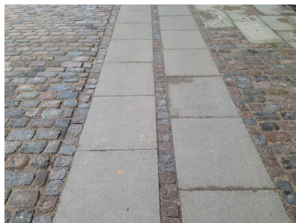
Figur 76: Københavnerfortov, type 4A. Foto forfatteren.
