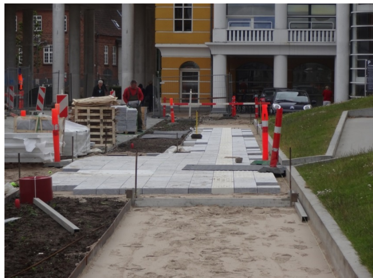
Figur 1: Fortov under anlæg i Svendborg. Selvom der er naturlige ledelinjer i begge sider, etableres også en kunstig ledelinje i midten af fortovet. Det var et krav fra det lokale handicapråd (oplyst i interview i anden sammenhæng). Foto forfatteren.
