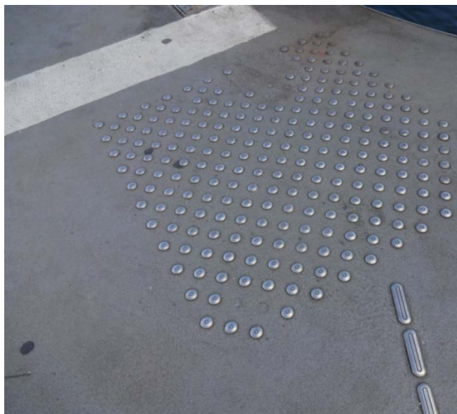
Figur 23: Pictoform-opmærksomhedsfelt og ledelinjeelementer på Tranegravsbroen i København. Foto forfatteren september 2015. Broen er indviet i januar 2015. Allerede 8 måneder efter er taktil-elementerne begyndt at falde af.
