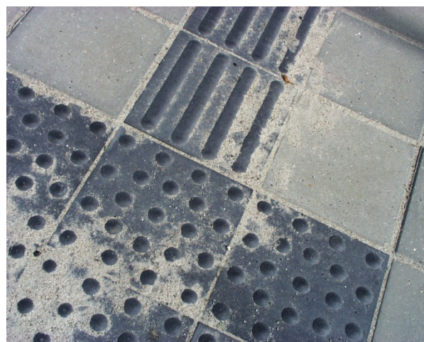
Figur 77: Intactila, integreret kunstig ledelinje, type 4B. Foto forfatteren.
