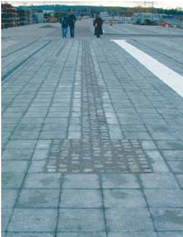
Figur 26: Prøvefelt med chaussésten fra den svenske undersøgelse (Vägverket, 2004, s. 16).
