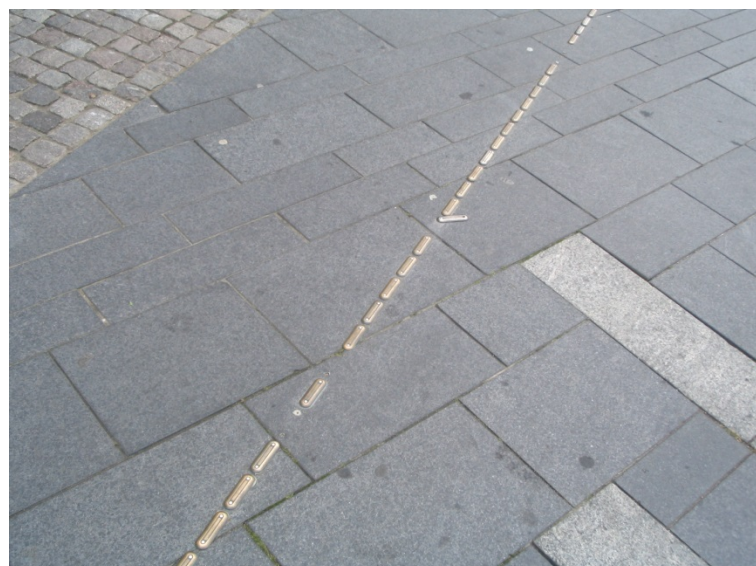
Figur 21: Pictoform-ledelinje, påmonteret type („marcipanbrød“). Foto forfatteren.
