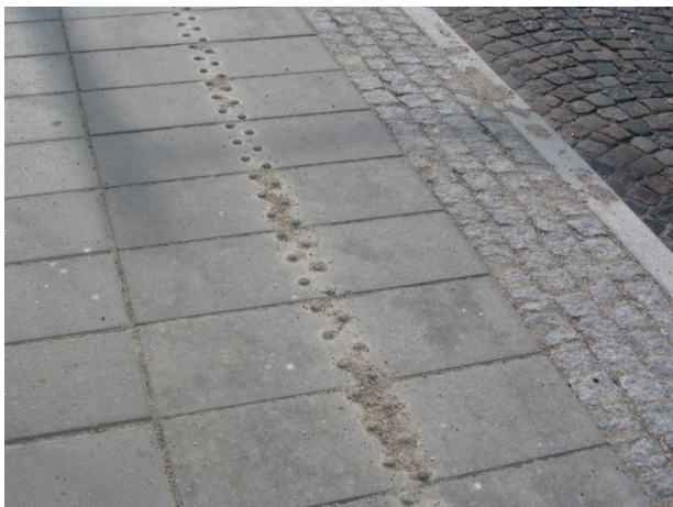
Figur 38: Ledelinje ved Lyngby Station, som Peter vælger at gå ved siden af. Ledelinjen består af 2 rækker knopper, der er støbt ind i betonfliserne. Foto forfatteren.
