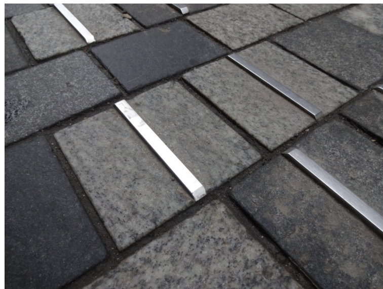
Figur 44: Nærbillede af ledelinjeelementerne Foto forfatteren.
