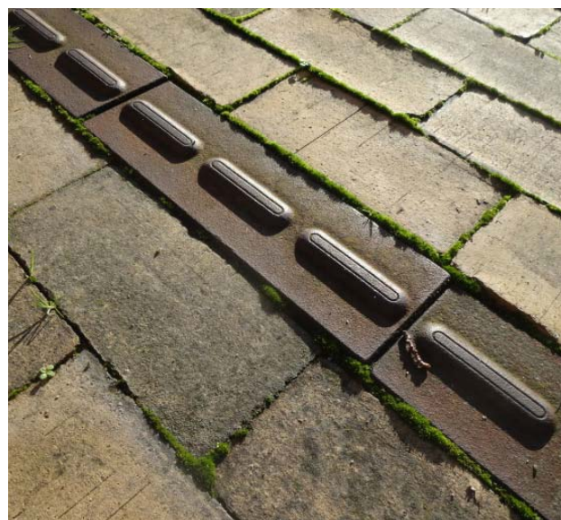
Figur 17: Pictoform, integreret type. Foto forfatteren.
