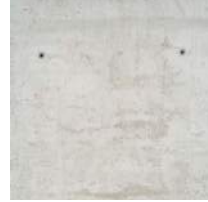
Søjler, Stømkantet, betonelement. Overflade formglat lys beton, farve aflæses på prøve.
