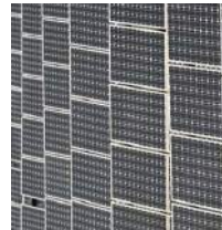
Solcelleanlæg placeres på tag af 'Lanterner' (byggn. A).
