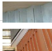
Atriumtrappe udføres fra etage 00-01 som betonelement med afslutning, der istøbtes profileret forkant. Monteres med afstand til væg på max. 30 mm. Gåkanaleret stål værn med træhåndliste.
