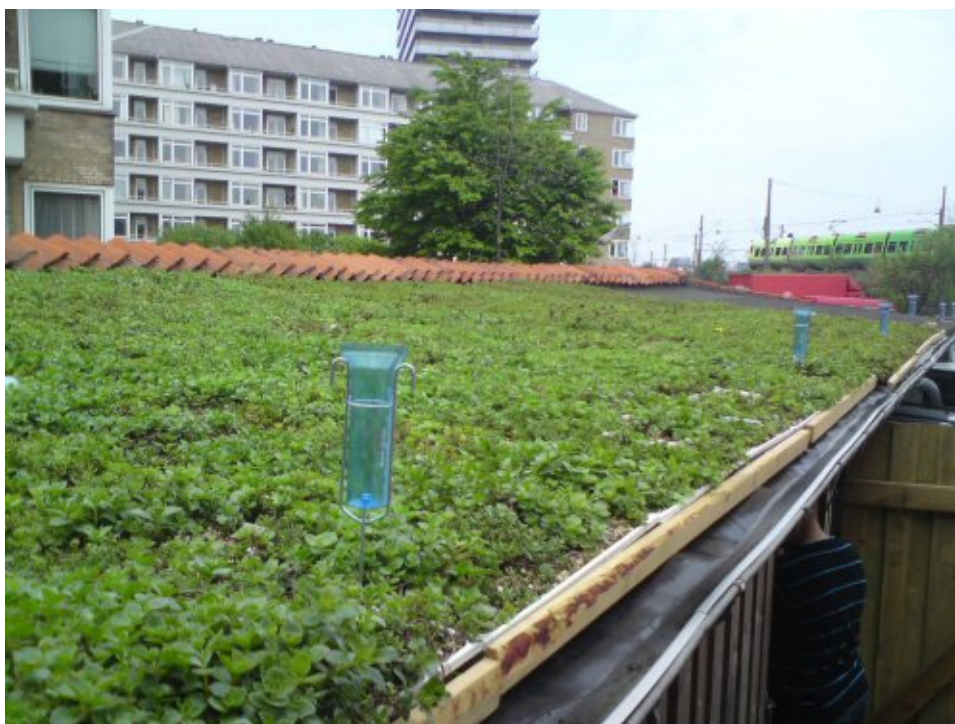
Figur 10: Billede af de grønne tage ved Østerbro brandstation (Teknologisk Institut)
