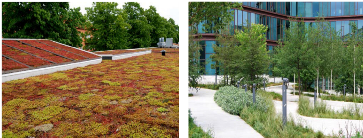
Figur 3: Det første billede viser et ekstensivt grønt tag i Augenstenborg, Malmö. Billede nr.2 viser et intensivt tag i Bymilen/SEB Bank og Pension, København. (Skov og Landskab, 2013)
