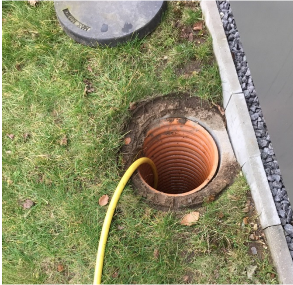
Figur 19: Opstillingen hvor vandslangen er sat ned i sandfangsbrønden
