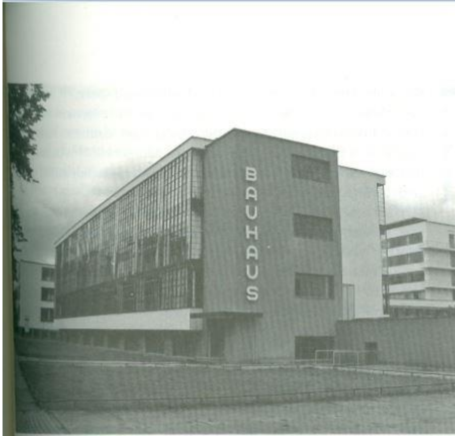
Walter Gropius, Bauhaus bygget i Dessau 1925-26. (Weitz.2007, 199)
