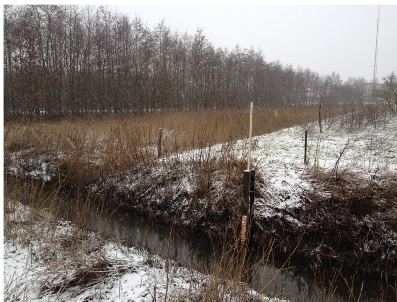
Figur 2.14. Dele af et inline-bassin placeret omkring målestation VL1.
