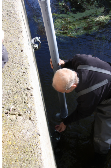
Figur 2.4. Montering af rør i påsatte rørholdere.
