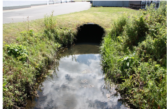
Figur 1.8. Udløb fra rørlagt strækning i Øster Landgrøft.
