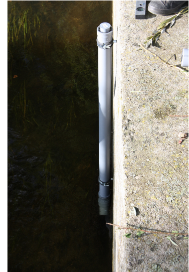
Figur 2.5. Færdigmonteret rør ved målestation ØST3.
