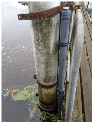
Figur 2.7. Målestation VL3 monteret på nedlagt målestation i ved Vester Landgrøfts indløb til Østerå.
