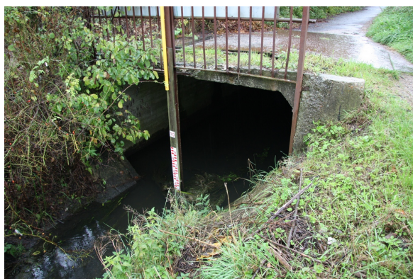
Figur 5.2. Indløb til 1,2 km lang rørlagt strækning i Vester Landgrøft.
