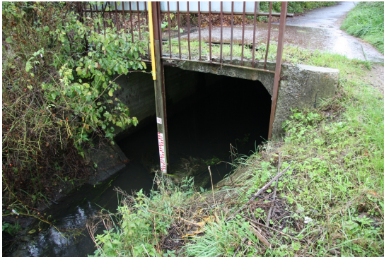
Figur 1.7. Indløb til rørlagt strækning i Vester Landgrøft.
