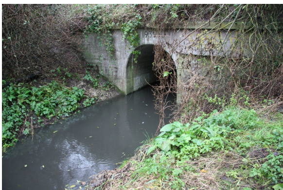
Figur 5.4. Bredt og højt udløb fra kort rørlægning i Vester Landgrøft.
