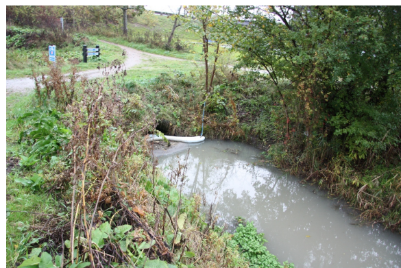
Figur 5.5. Betydelig indsnævring ved indløb til kort rørlægning i Øster Landgrøft (denne indsnævring ligger uden for projektlokaliteten).
