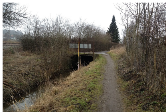
Figur 5.2. Indløb til 1,2 km lang rørlagt strækning i Vester Landgrøft.
