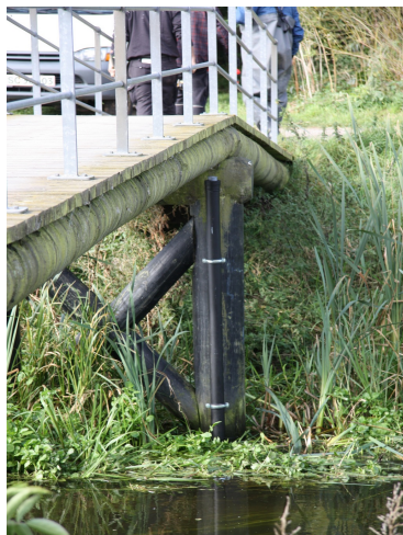
Figur 2.8. Målestation ØST2 monteret på bropille i Østerå.
