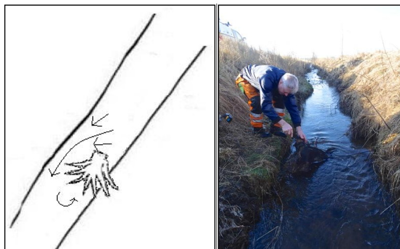
Figur 4.6 Til venstre: Konceptuel tegning af en rodklumps placering i et kanaliseret vandløb. Pilene symboliserer de forventede strømningmønstre omkring rodklumpen (egen figur). Til højre: Åmand Svend Erik Valbjørn fastmonterer en rodklump med en wire i Grundel Bæk (eget billede).
