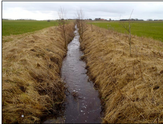
Figur 5.3 Grundel Bæk fra første indsatsstrækning og opstrøms. På billedet ses, at Grundel Bæk er sænket under terræn og oplandet primært består af landbrugsjord (eget billede).
