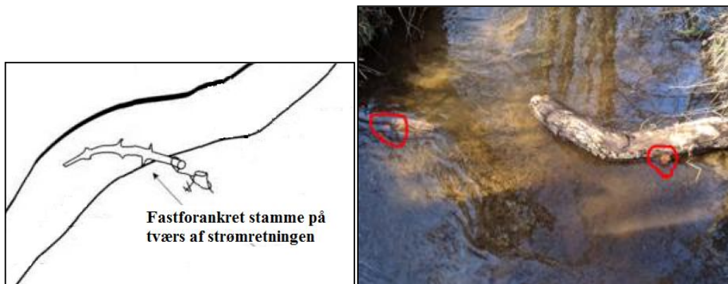
Figur 4.5 Til venstre: Metode hvor en træstamme fastforankres med wire (modificeret fra Cederholm (1997)). Til højre: Den praktiske udførsel i Sandemandsbækken. Her er der banket en pind ned i vandløbsbunden, som stammen er skruet fast til (eget billede).
