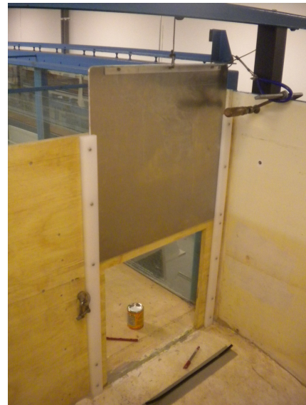
Figur 5.7. Spjæld set fra opstuvningskammer.
