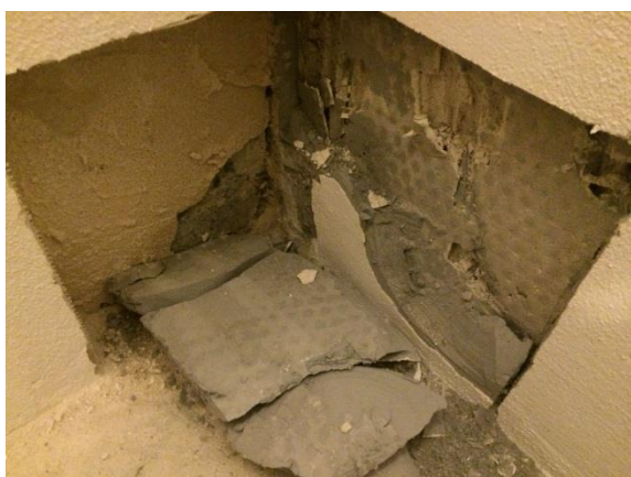
Billede 6 Åbning S1 i Skamol plade ved hjørne mod Ytong. Bagside af plade og hjørne i åbninger ses tydeligt våde.
