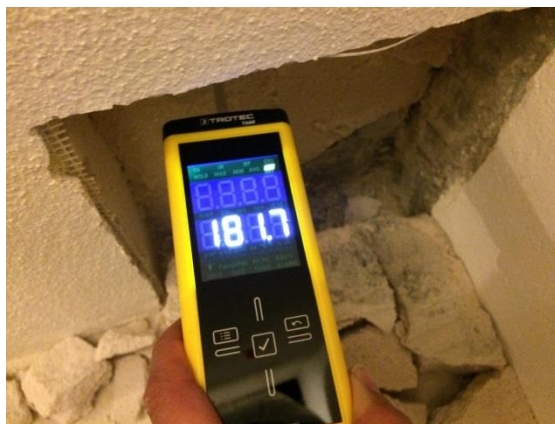
Billede 53 Fugtmåling i åbning Y1, der viser kraftig opfugtning
