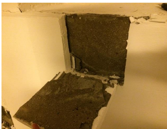
Billede 19 Åbning M2 i MicroTherm plade, hvor der var tydelig revne mellem plade og væg. Plade inkl. klæber har helt mistet vedhæftning og kan tages ud i et stykke
