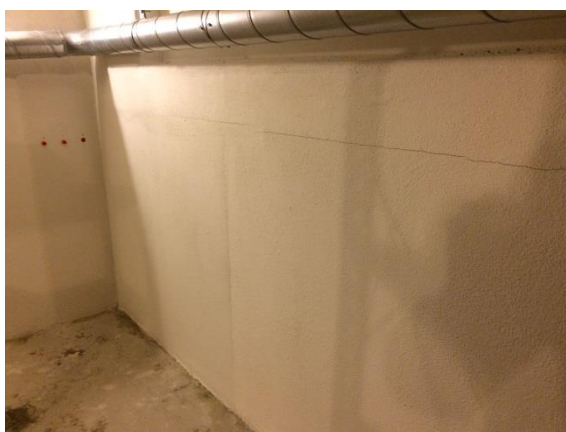
Billede 114 Vandret revne ved pladesamling på 25 mm Skamol plader
