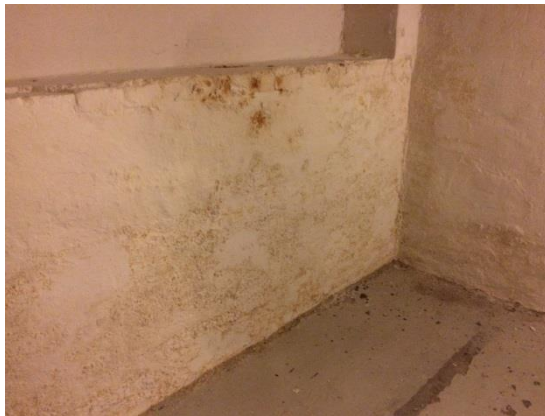
Billede 3 Ydervægge ved senere gennemgang. Der er søgt udbedret med drænpuds og diffusionsåben overfladebehandling, men der ses tydelige fugtskjolder og misfarvning af skimmelvækst
