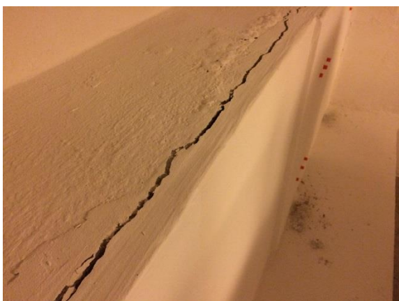
Billede 10 Tydelige langsgående revne mellem MicroTherm plade og murværk i brystningsniche
