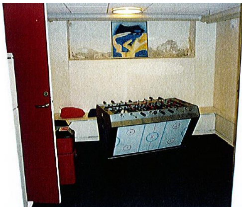
Billede 2 Det ene af de to kælderrum, hvor pågældende forsøg er udført. Her før første udbedring, hvor der kan ses fugtskjolder i niche bagerst. Der er desuden træbeklædning på ydervæg
