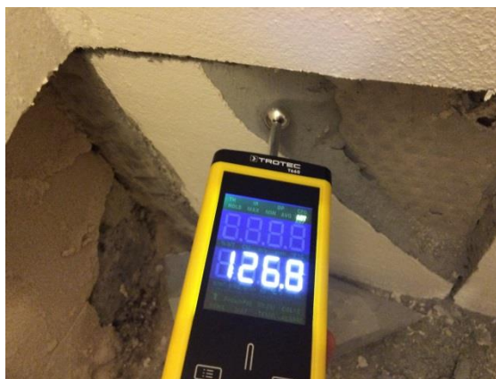
Billede 15 Åbning S1 i Skamol plader, hvor plade sidder relativt godt fast, men slipper i klæbelag. Fugtniveau målt i plade viser kraftig opfugtning.
