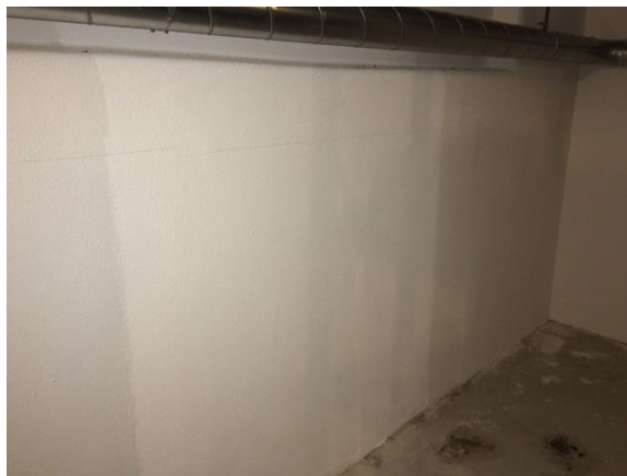
Billede 5 Færdig væg i Rum 2, hvor MicroThermplader er overfladebehandlet med tre forskellige produkter – Silikat, WeberTon 411 og Biorid
