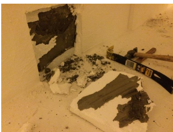
Billede 20 Åbning M3 i MicroTherm plade. Pladen går delvist i stykker ved udtagning. Klæberen deles i de to lag
