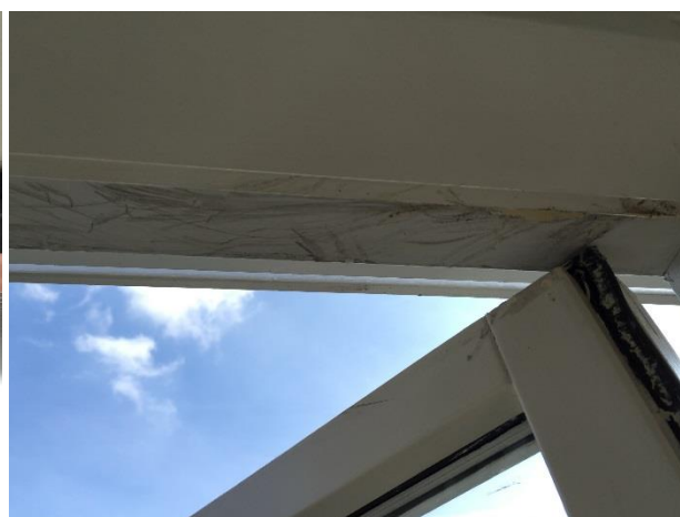
Figur 63 - Tætningslisten har skrabet på overkarmen gennem længere tid, uden indgriben fra beboeren Afd. 331
