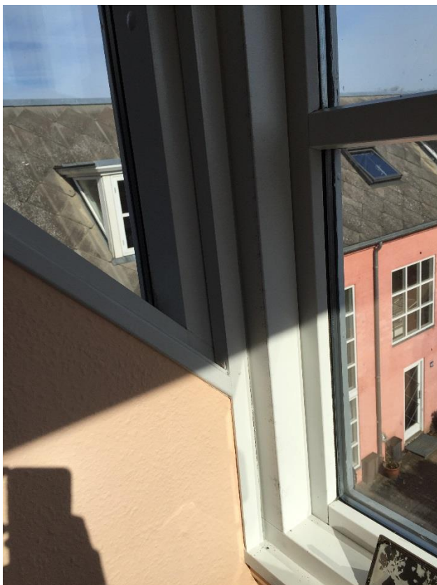
Figur 39 - Vindue i en kvistflunke i afd. 331
