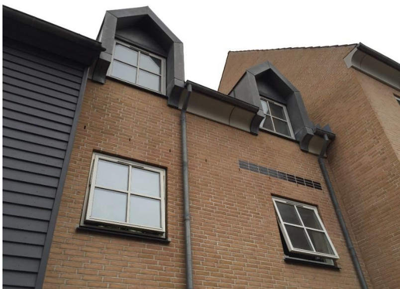
Figur 61 - Billede af et vindue med god indbygningsdybde i kvisten, hvilket giver en god konstruktiv beskyttelse Afd. 040
