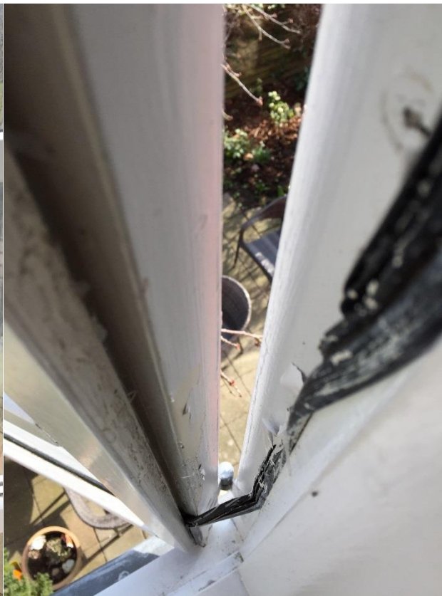
Figur 45 - Tætningsliste der er "malet" fast Afd. 331
