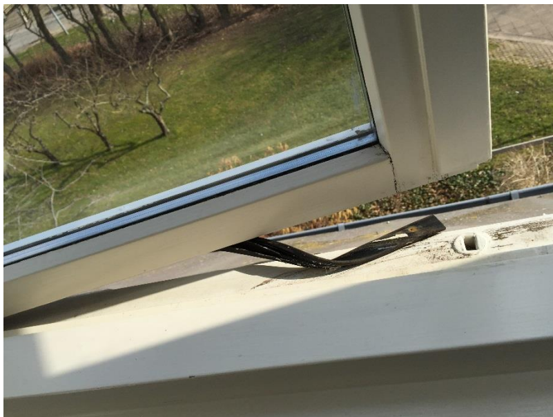
Figur 49 - Glasbåndene har det ok, i modsætning til tætningslisterne afd. 331
