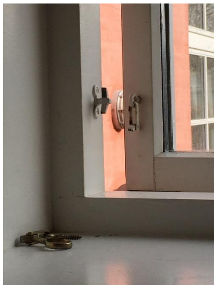
Figur 41 - Knækket anverfer i afd. 331
