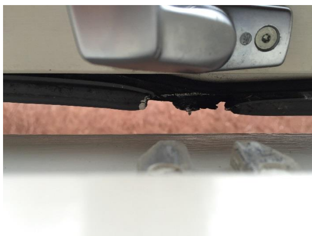
Figur 62 - Manglende indgriben fra beboernes side, så tætningslisten bliver beskadiget Afd. 040
