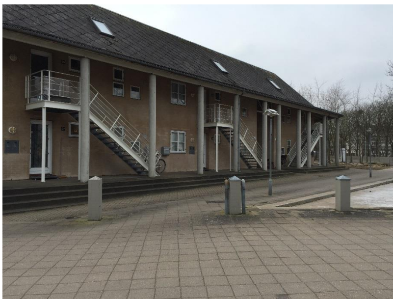
Figur 52 - Billede af udhæng på ca. 1/6 af vinduerne i afd. 331.
