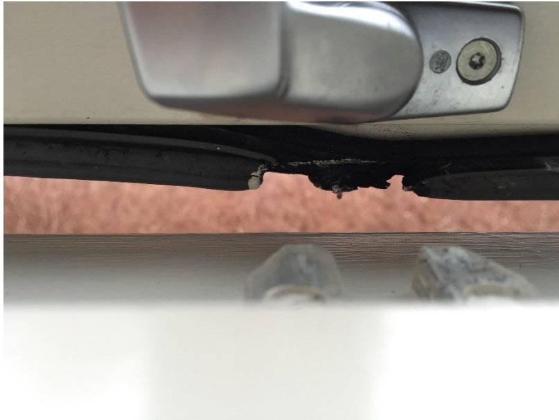
Figur 46 - To karakteristiske huller i tætningslisten Afd. 040
