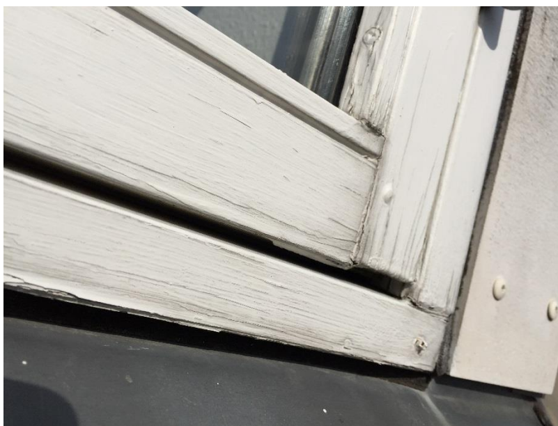
Figur 48 - Vindue i Afd. 331, det er 5 år siden de sidst er blevet malet
