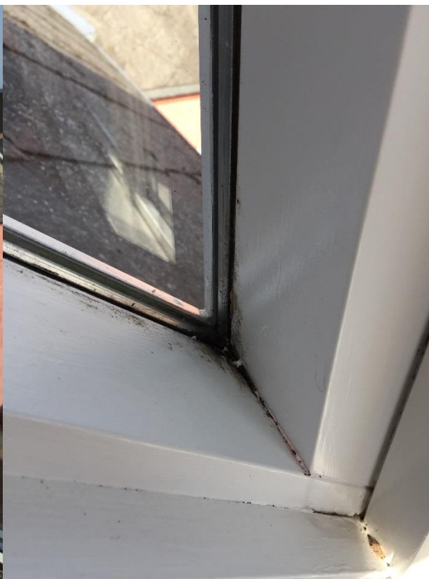
Figur 40 - Bund af kvistflunke vindue, hvor der ofte ses skimmel
