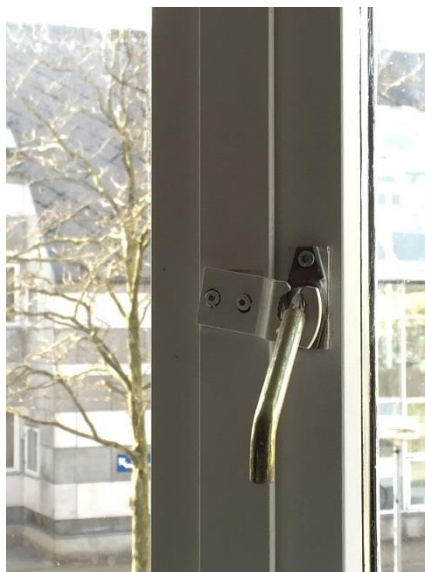
Figur 42 - Defekt børnesikringsbeslag
