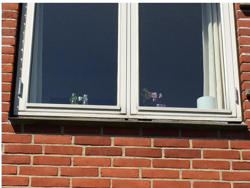
Figur 47 - Fuge under vindue er helt defekt Afd. 338
