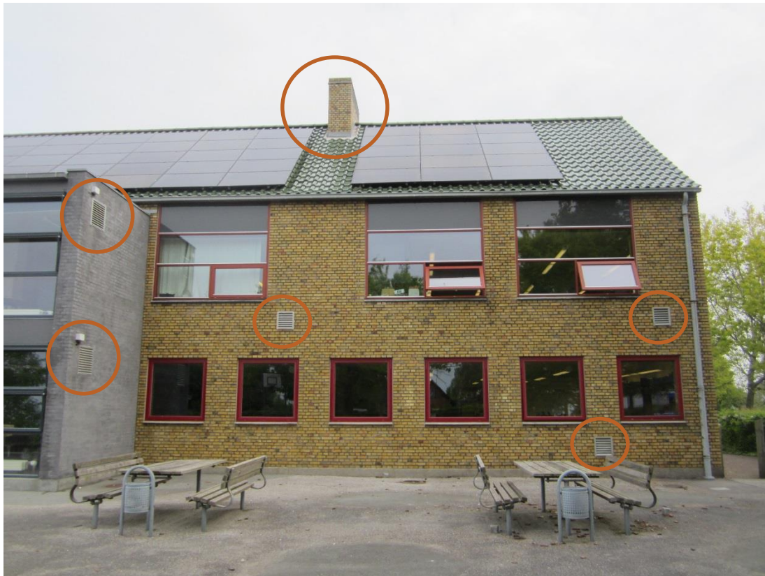
Figur 32 – Foto af sydvendt facade fra skolegård. På fotoet er markeret udeluftsspjæld i facaden, samt skorstenen, som fungerer som afkast fra udsugningen.
