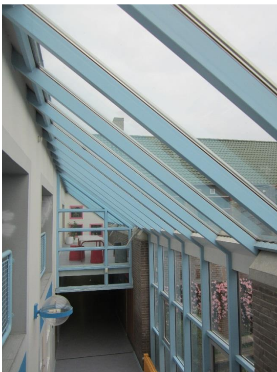
Figur 53- foto af glasmellemgang ved 8a, bemærk oplukkeligt vindue med motor.
