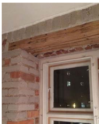
Billede 3: Foto af typisk overligger/murpille, for en 2,5 stens mur.
