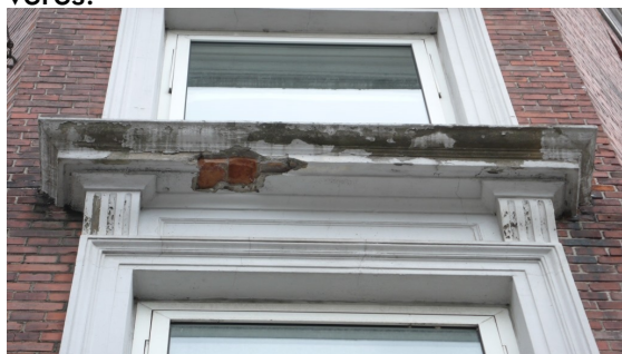
Figure 24 - foto af fordakning
