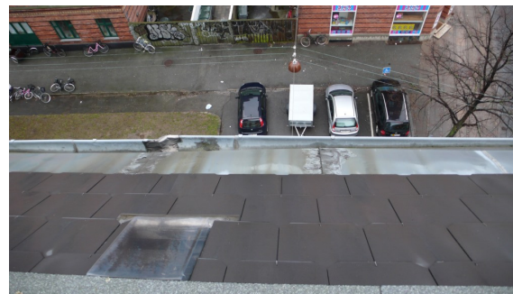
Figure 18 - foto af skråtag mod gade
