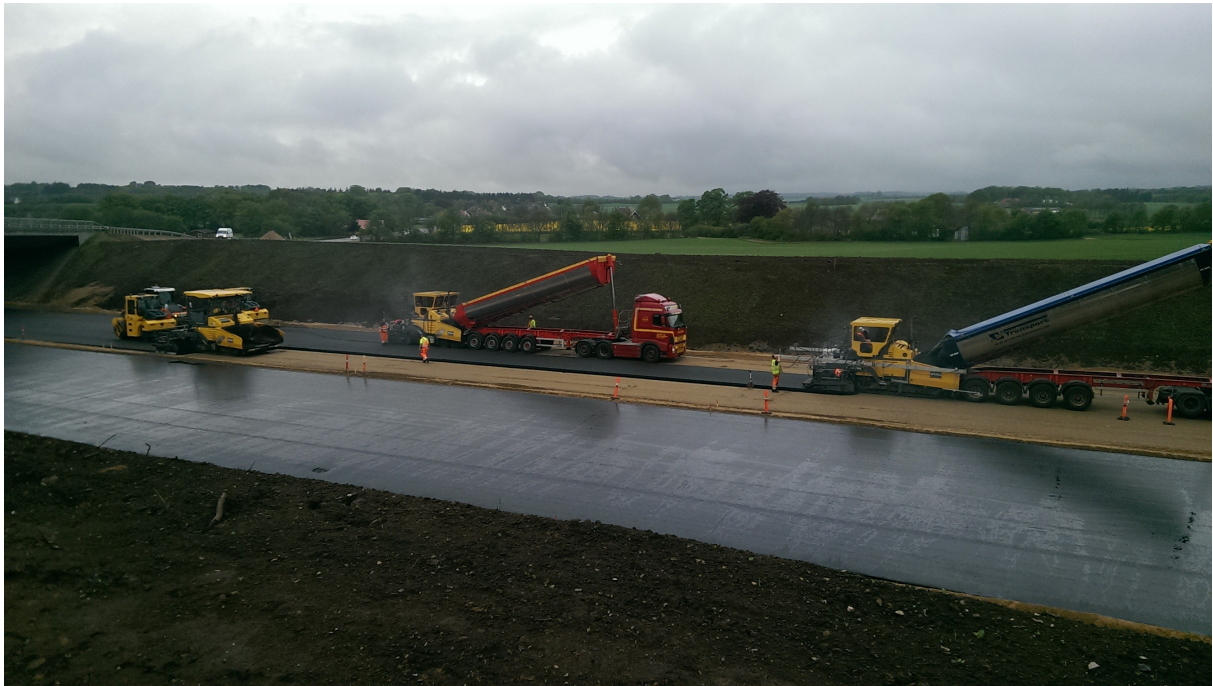
Illustration 2: Asfaltudlægning på Silkeborgmotorvejen.
