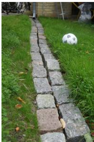
Figur 4.1: Eksempel på afledning af tagvand til grøft. [Teknologisk Institut, 2013], [Hillerød Kommune, 2013]
