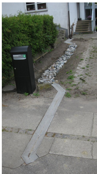
Figur 4.1: Eksempel på afledning af tagvand til grøft. [Teknologisk Institut, 2013], [Hillerød Kommune, 2013]
