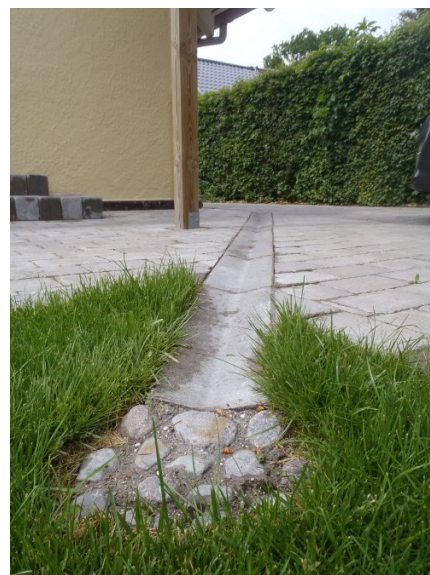
Figur 4.1: Eksempel på afledning af tagvand til grøft. [Teknologisk Institut, 2013], [Hillerød Kommune, 2013]
