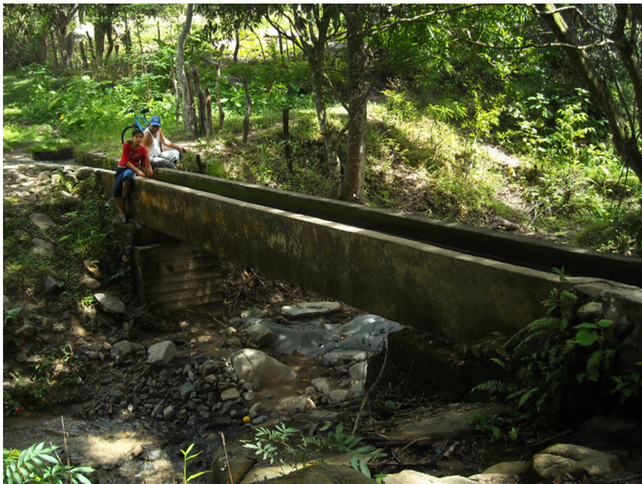
Figur 4.8: Eksempel på en mindre akvædukt. [Guardabarrancosa, 2012]
