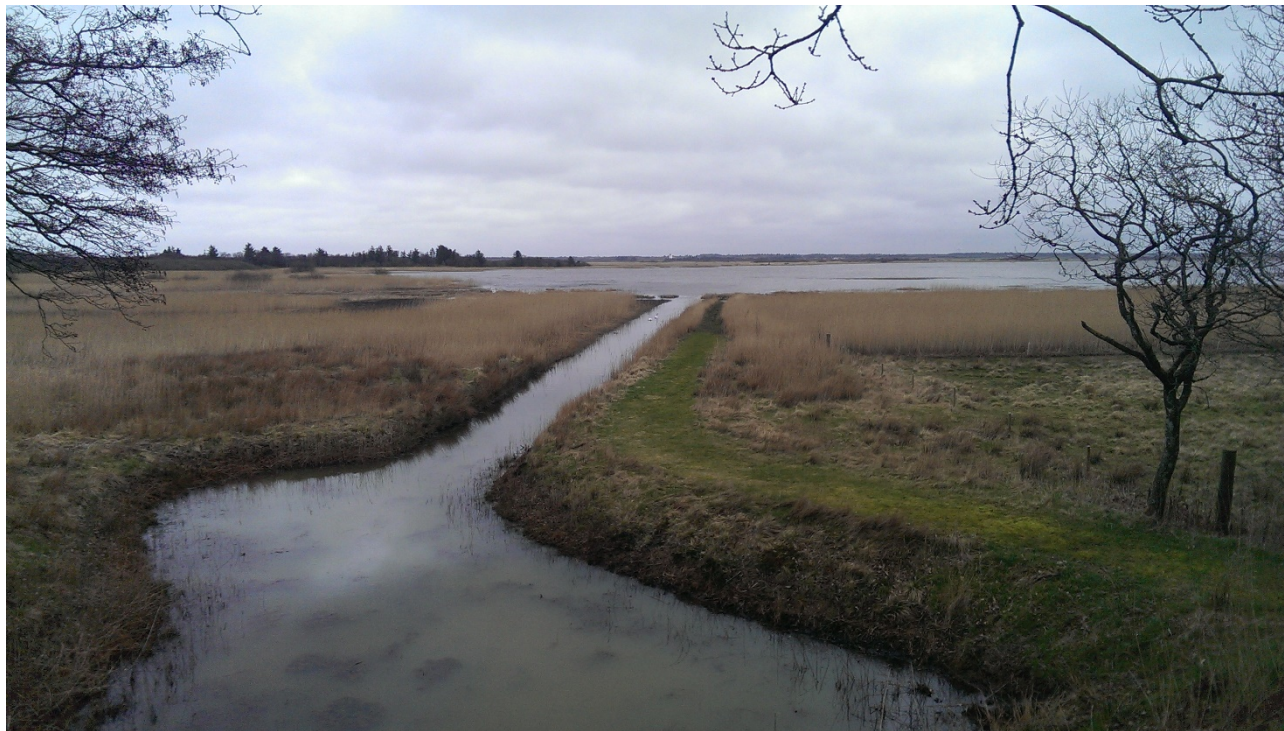
Figur 8 Kaj Munks kanal fra haven til Bæversø
