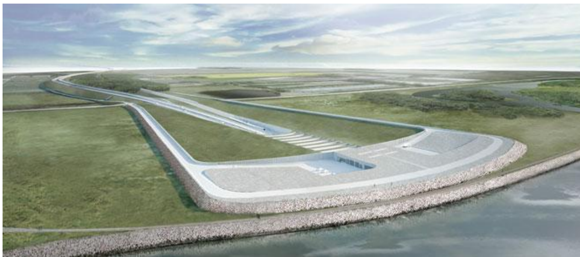
Illustration 5. Illustrationen viser anlægget, hvor tunnelen møder landjorden. Forbindelsen omfatter en fire-sporet motorvej og en dobbeltsporet, elektrificeret jernbane ( www.ramboll.dk ).
