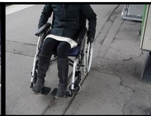
Huller i belægningen er ikke nemme at passere
