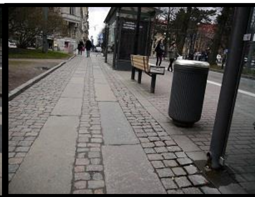
Og kørestriber er anlagt. Det ses også hvordan bænke er opstillet.
