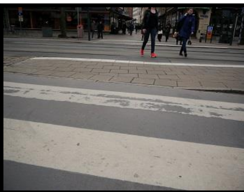
Fodgængerfelter er i mange tilfælde sænket ned.
