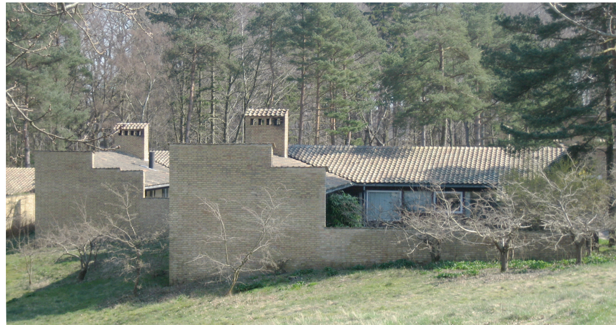
ill. 31. exterior kingohusene
