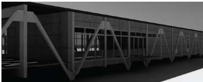
Konstruktionen i liv (niveau) med facaden.
