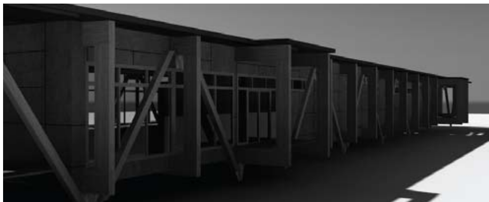
Rammer og tagudhæng trukket ud ved indgang og mellemrepos.
