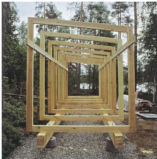
ill.: 48-1 Eksempel på et overordnet koncept for det strukturelle system.
