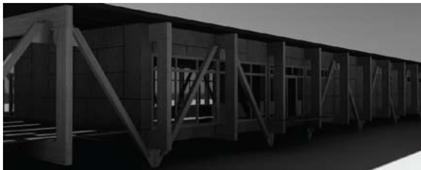
Konstruktionen friholdt fra facaden.
