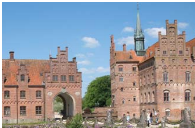
ill.: 45-3 Egeskov 1554. Oprindeligt havde bygningen rundbuegavle; Ombygget ved restaureringen i 1880'erne.
