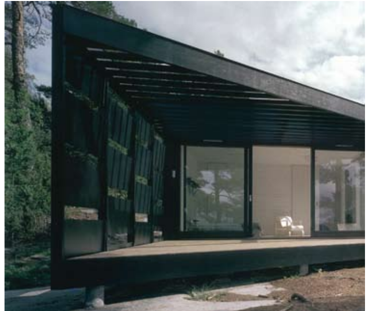
ill.: 107-1 Eksempel på mørk træpladebeklædning udendørs.
