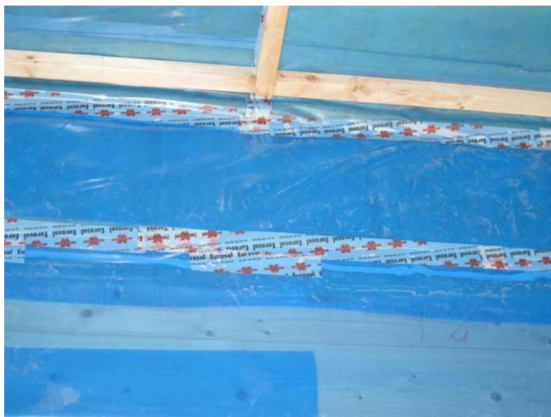
Figur 9.3: Figuren viser en samling i dampspærren med hæfteklammer og tape.
