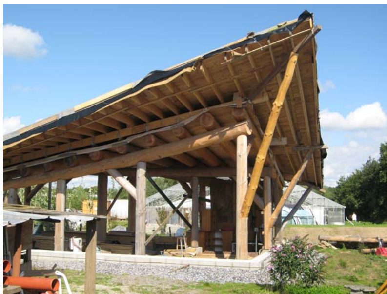
Figur 6.1: Figuren viser et halmhus der er under opførsel, hvor rundtømmer skal være bærende og synlige.
