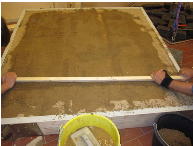
Figur 16.15: Viser hvordan glitningen blev udført umildbart inden testelementet var færdig glittet.
