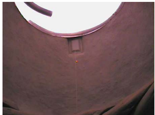
I forbindelse med tæthedsprøvningen er der ikke tætnet tilstrækkeligt v. friskluftventil i loft
