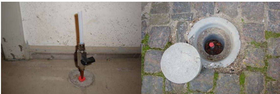
Figur 1. Målepunkter. Billedet til venstre er fra kælderen, men billedet til højre er fra en poreluftssonde placeret langs bygningens fundament.
