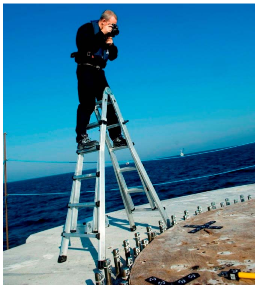
Figur 5.4: Eksempel på detaljeret afleveringskontrol af bolte i vindmøllefundament i overgangen mellem betonentreprise og mølleleverandør. Kontrollen blev gennemført vha. fotogrammetri. [Zebicon, 2009a]
