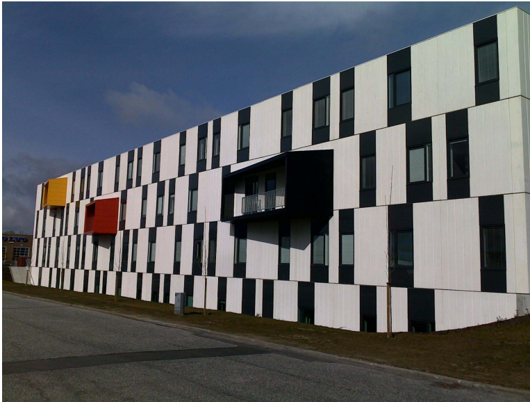
Figur 6.3: Foto af facaden på bygningen der danner grundlag for den praktiske demonstration af konceptet.
