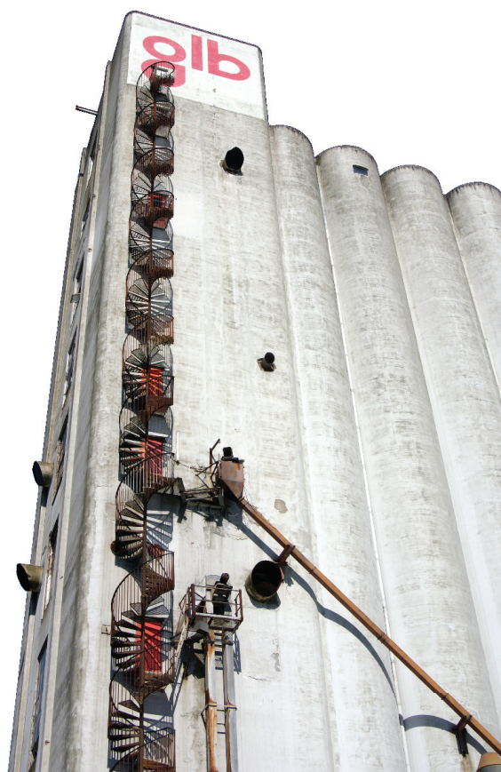
FIGUR 9.5.33 silo i aalborg med karakteristisk trappe
