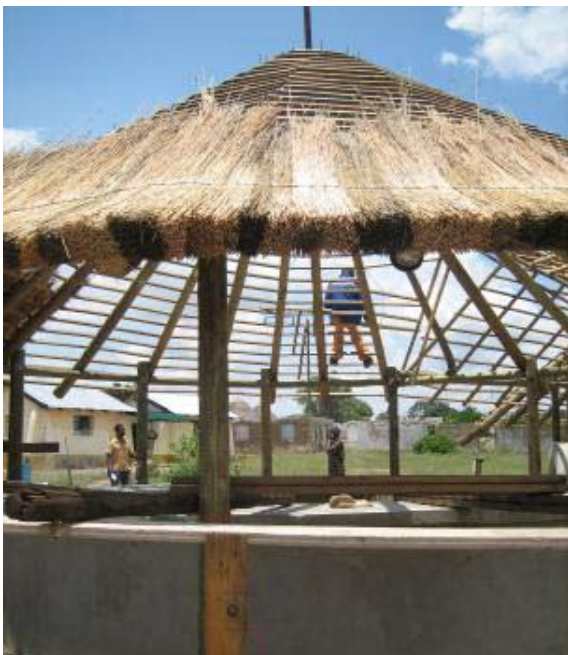
III.123 Under opførelsen af det udendørs køkken.
