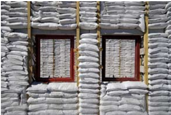
Ill.107 Konstruktionen består af et træskellet udfyldt med sandsække.
