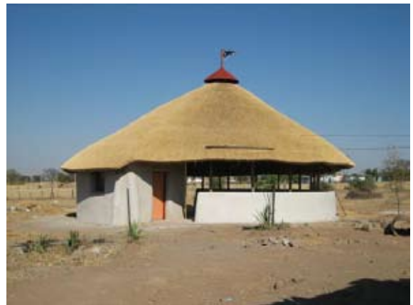
III.119 Bygningen er opført med sandsække og stråtag.
