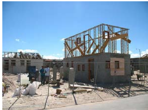
Ill.106 Konstruktionen beklædes til sidst med plader.
