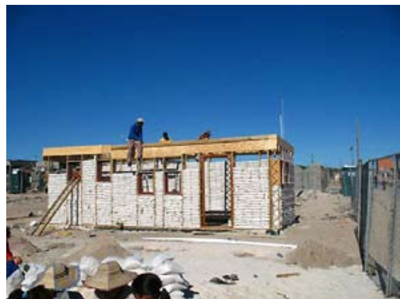
Ill.108 Konstruktionen er lige så stærk som en muret væg af mursten og mørtel, men er lettere at konstruere.
