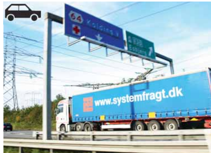
Fig. 63 Infrastrukturlandskab ved motorvejen
