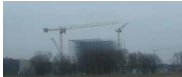
Fig.4 Indkøbscenter under opførelse i Århus. Centeret ligger placeret ud til motorvejen og kommer blandt andet til at indeholde flere dagligvarerbutikker
