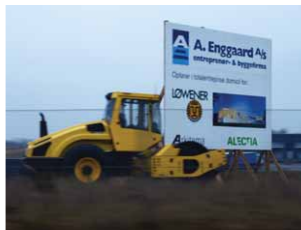
Fig.6 Byggeri under opførelse langs E45
