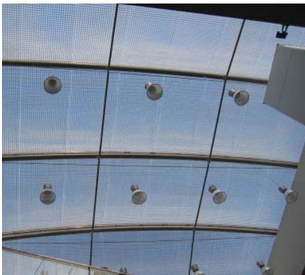
ill.166 Tagkonstruktion i ETFE, NRGi-bygningen i Århus
