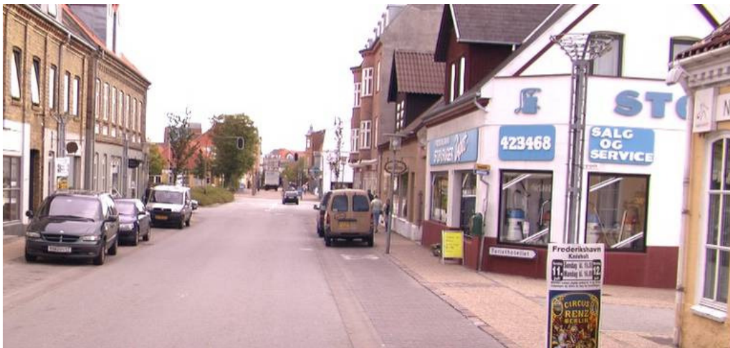
Figur 5.2. Søndergade i Frederikshavn. Et eksempel på en ombygning, hvor asfalkørebanen er bevaret, men hvor vejbanen er indsnævret, og der er etableret langsgående parkering og beplantning.
