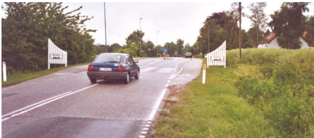
Figur 5.4. Et eksempel på et miljøprioriteret gennemfartsprojekt. Her er der markering af byzonen med porte og belægningsskift, cykelsti og efterfølgende midterhelle.
