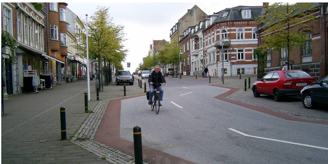
Figur 5.3. Adelgade i Skanderborg – Her er der parkering, pullerter og beplantning langs vejen. Vejen har forsætninger, og der lagt et rødt bånd på langs i hver vejkant.
