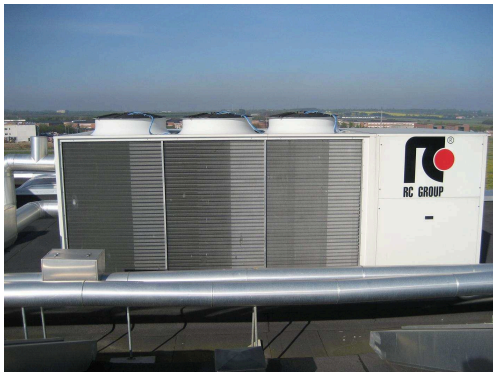
(c) Køleanlæg til anlæg VE01 og VE02
