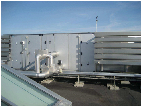
(a) Ventilationsanlæg VE01
