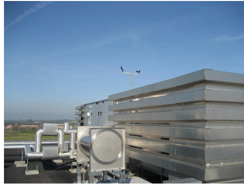
(b) Ventilationsanlæg VE02
