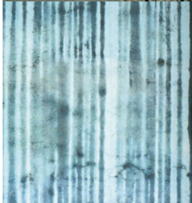
Eksempel på en betonmur, hvor kobber har været blandet i og vand er løbet over. (Gigon/guyer - Reinhart collection)
