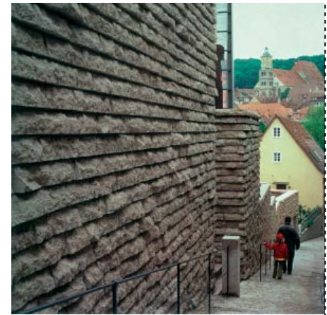
Eksempel på mur med sten, der overlapper, Kunsthalle Wurth, schwabisch hall Tyskland af Henning Larsen
