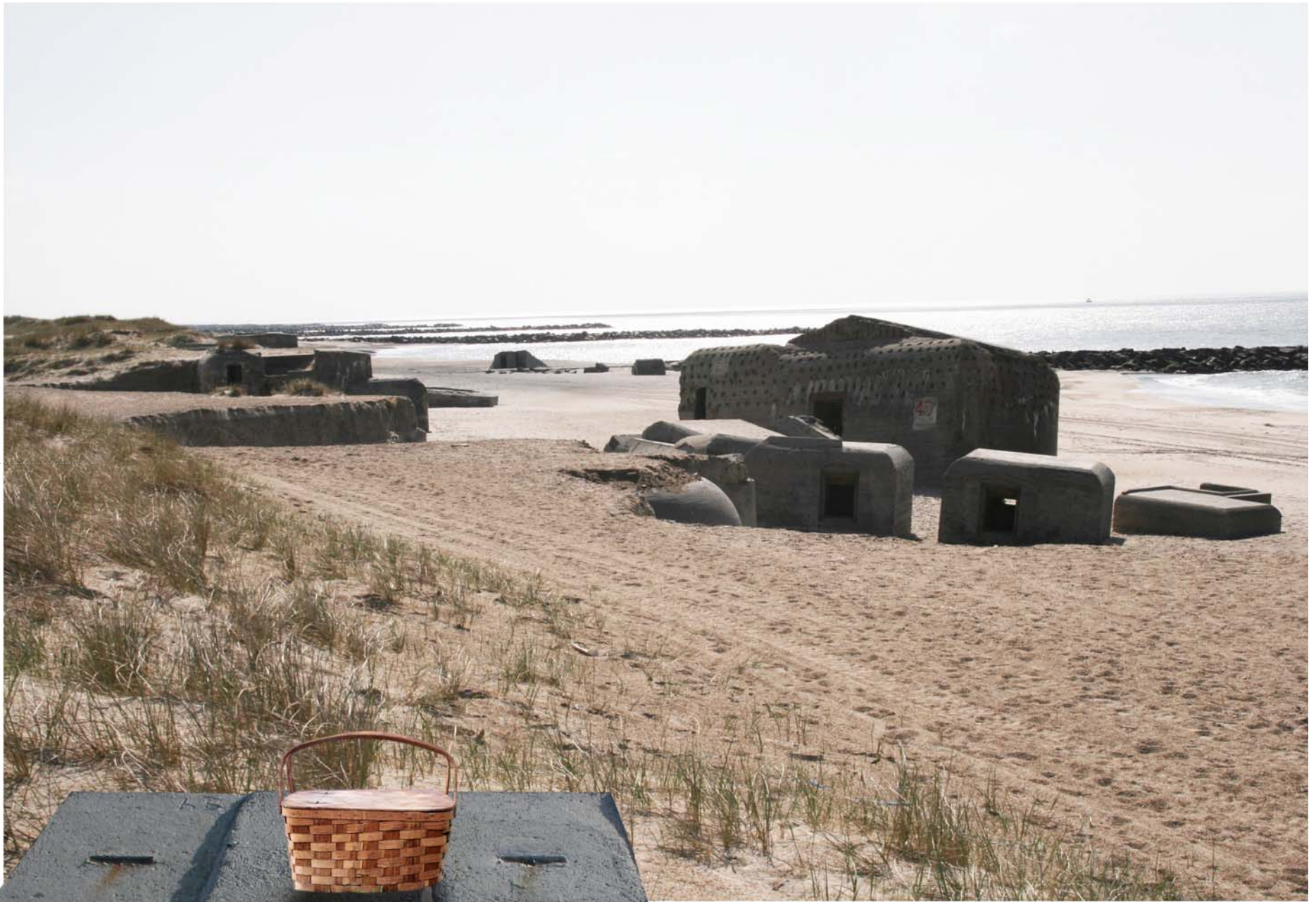
MONTAGE Kystsikringsblokke i klitterne danner små intime opholdssteder
