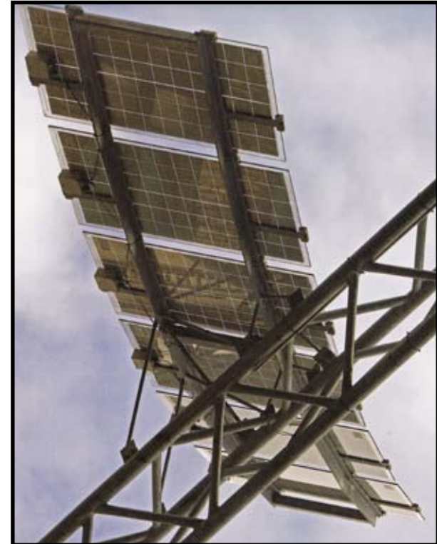
Solcelleanlæg i Eriksgade i København Kilde: Solceller + arkitektur, 2005
