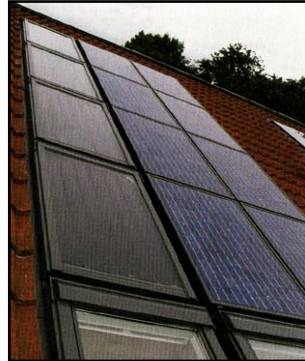
Solvarme- og solcelleanlæg side om side. Kilde: Solceller + arkitektur, 2005
