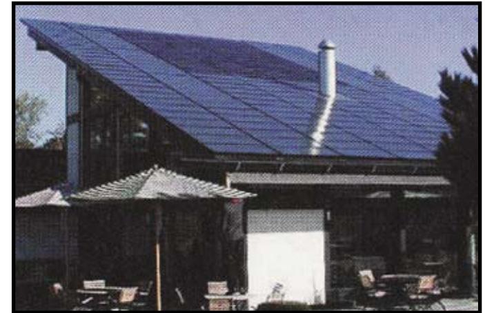
Typehus ved Hamborg. Solceller integreret i tag. Kilde: Solcelleanlæg i større byggerier
