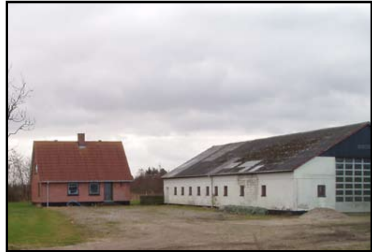
Husmandsstedet set fra nordsiden. Stuehuset benyttes idag til indkvartering af overnattende gæster. Driftsbygningen benyttes som lager.
