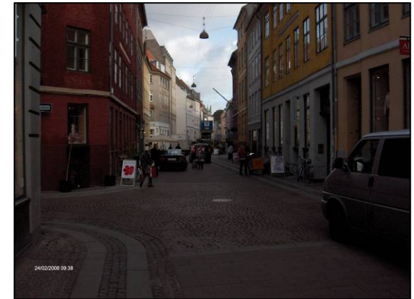
Figur 9.15 Belægningen i Strædet med betonfliser på kørearealet.
