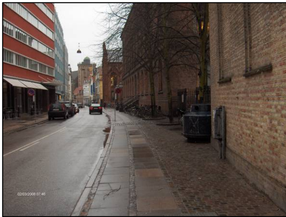
Figur 9.7 Krystalgade med Københavnerbelægningen på gangarealet og sidearealet udført med brostensbelægning.
