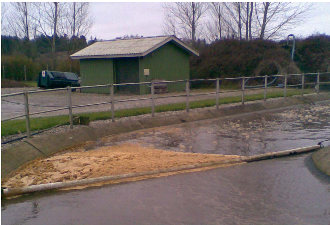
Figur 11: Skummets udbredelse efter 3 ugers dosering med BC-100 (dag 105)
