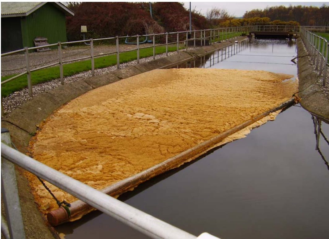
Figur 10: Skumdannelse på anlægget ved doseringsstart (dag 83)
