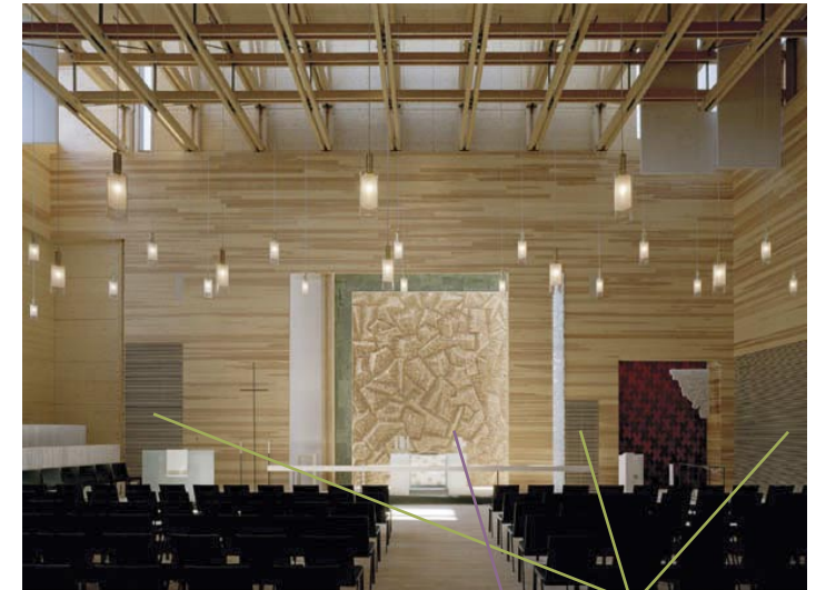
SALEN MED DEN DIFFUSERENDE ALTERTAVLE OG LAMELLER TIL LYDABSORPTION
