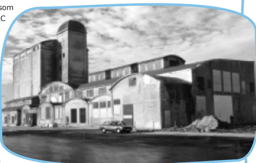
Figur 21 De karakteristiske industribygninger var med til at give området identitet, og kommunen ønskede de mest markante genanvendt. [Aalborg Kommune 2000, s. 2]
