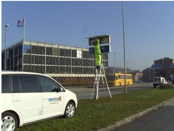
Figur 61. Medarbejder fra Swarco Danmark A/S reparerer en dynamisk henvisningstavle i Randers.
